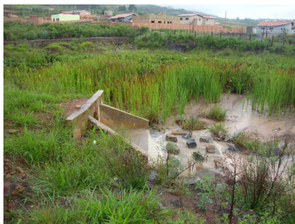
Figura 4 - Detalhe da Bacia de Detenção.
