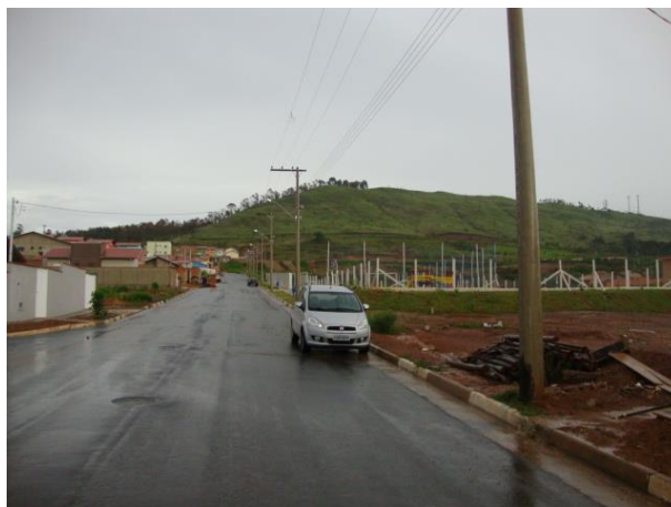
Figura 3 - Detalhe da condição das vias do loteamento.
